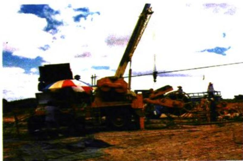
引进国外张力架线设备在架线
