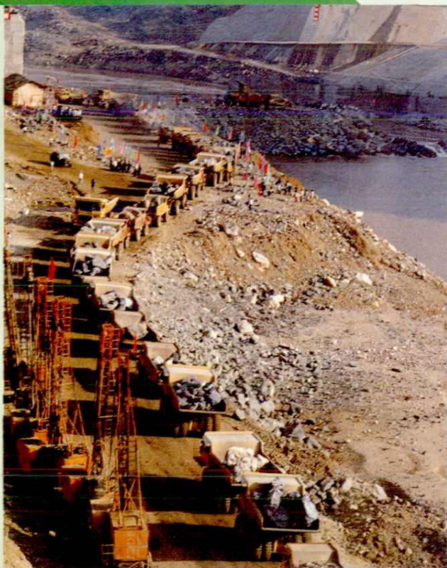
1987年11月1日，岩滩水电站 工程顺利完成了截流任务 尹世杰摄
