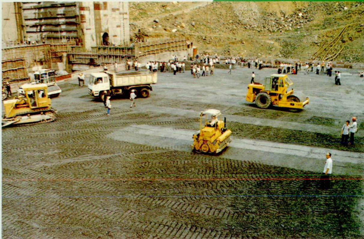
岩滩水电站大坝、围堰采用碾压混凝土施工的新技术
