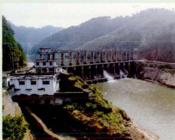
贺县临江水电站，装机总容量9400千瓦， 1974年12月建成发电
