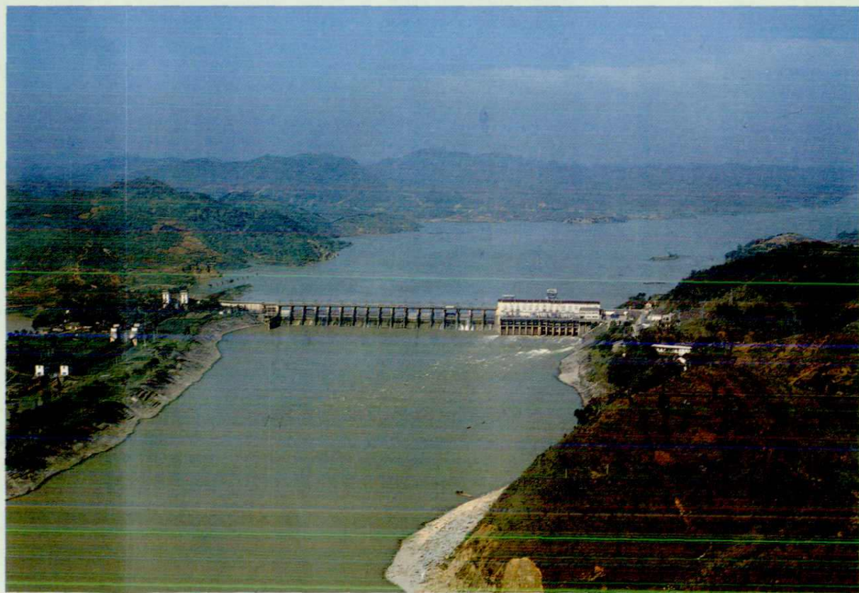
西津水电厂，装机总容量23.44万千瓦，1964年6月第一台机组建成发电
