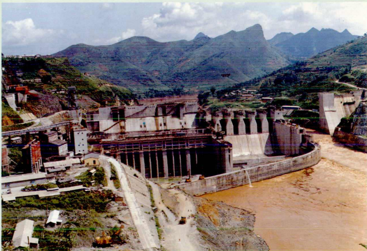
正在建设的岩滩水电站，装机 4 \times 30.25 万千瓦，第一台机组可望于1992年建成发电
