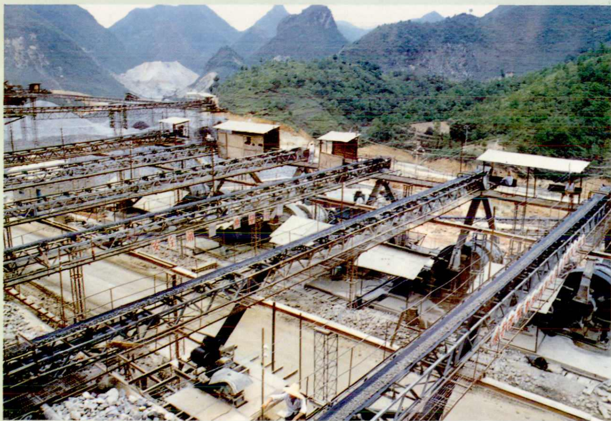
岩滩水电站人工砂石加工场，1985年建成投产，月产碎石10万立方米，砂4万立方米
