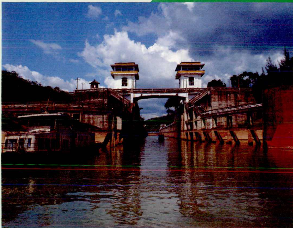
西津水电厂通航船闸，可通航 2 \times 1000 吨级船队，1966年元月建成通航
