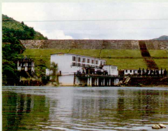
澄碧河水电站，装机 4 \times 6500 千瓦， 第一机组于1966年3月发电
