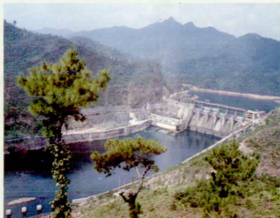
合面狮水电站，装机 4 \times 1.7 万千瓦， 第一机组于1974年9月建成发电
