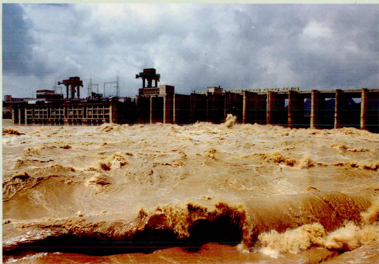
红水河大化水电厂，装机 4\times 10 万千瓦，1983年12月第一台机组建成发电
