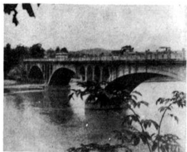
石花公路大桥
