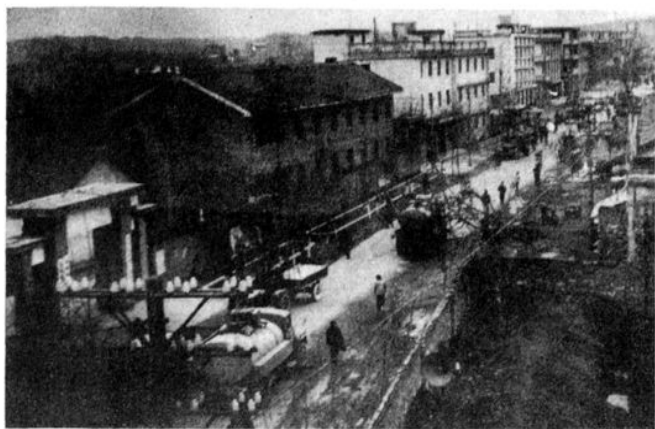
建设中的东门路
