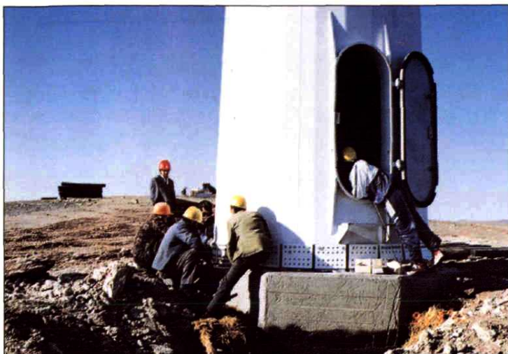
组装中的 600 千瓦风力发电机塔筒
