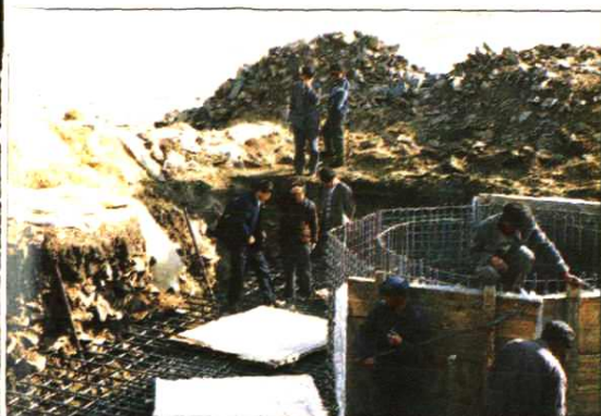
600 千瓦风力发电机塔筒基础
