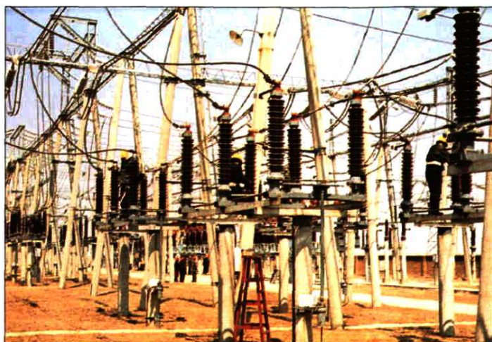
建设中的集宁 220 千伏变电站
