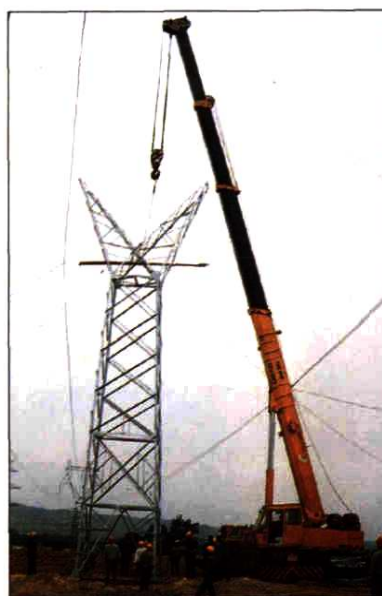
跨丰准铁路加高塔
