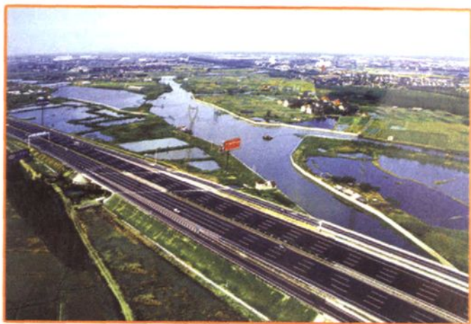
无锡历史上第一条高速公路 ——沪宁高速公路无锡段
