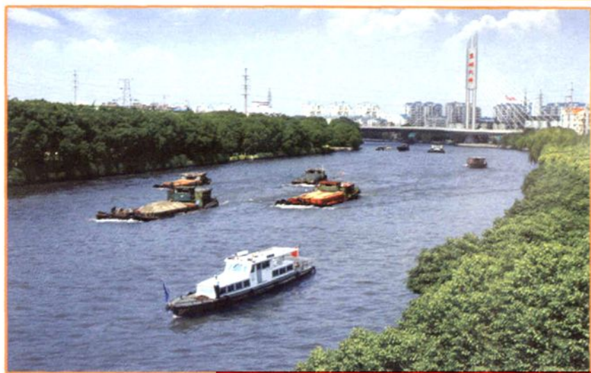
全程实施电子监控的苏南运河无锡段
