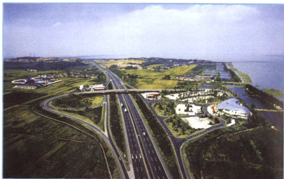
宁杭高速公路
