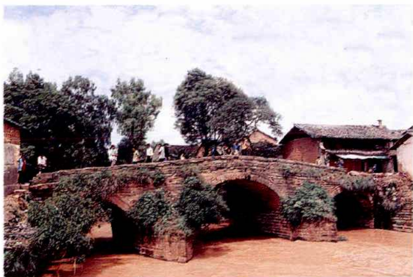
板桥大砂石桥
