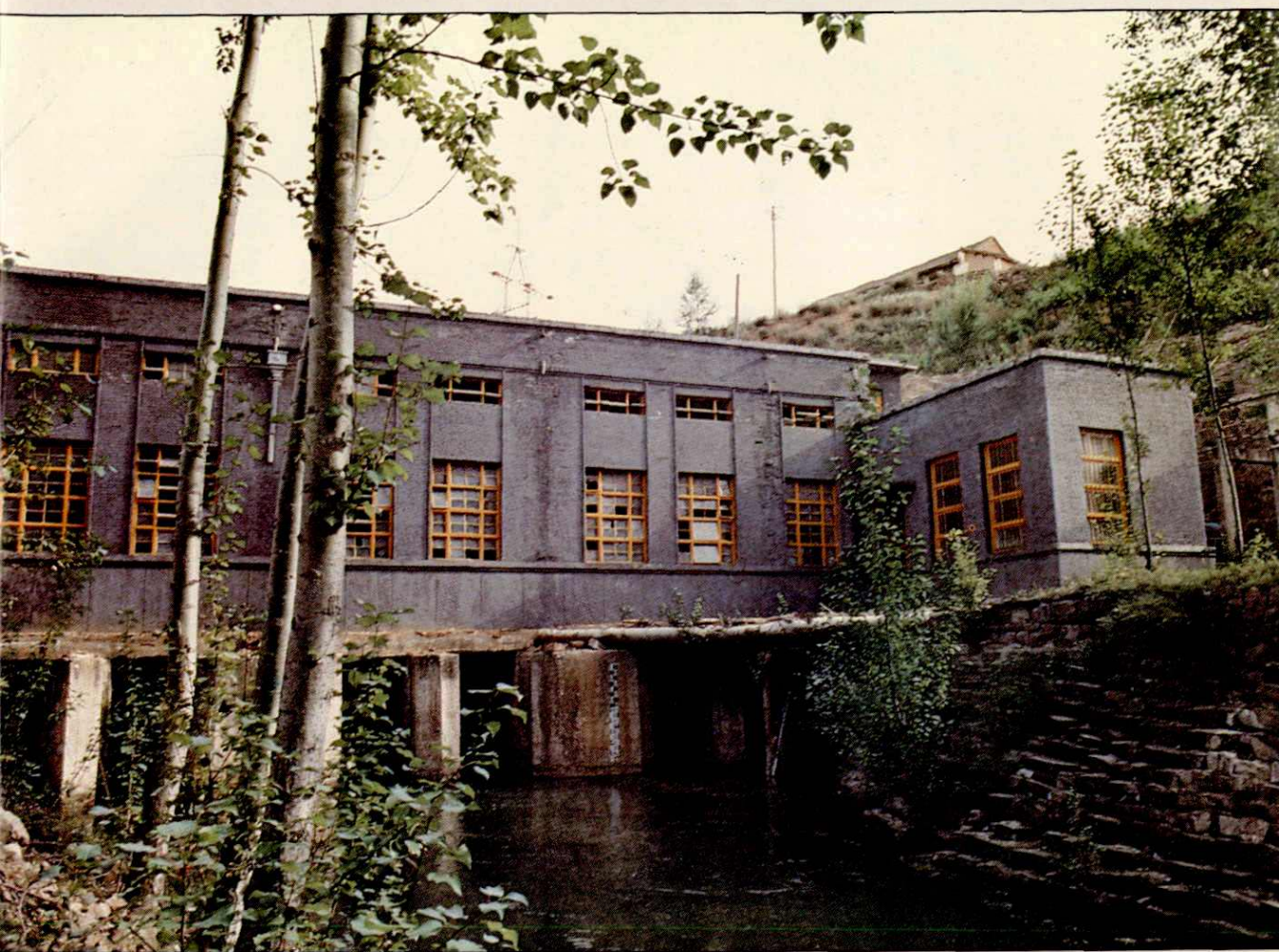
左权县石匣小水电厂厂房
