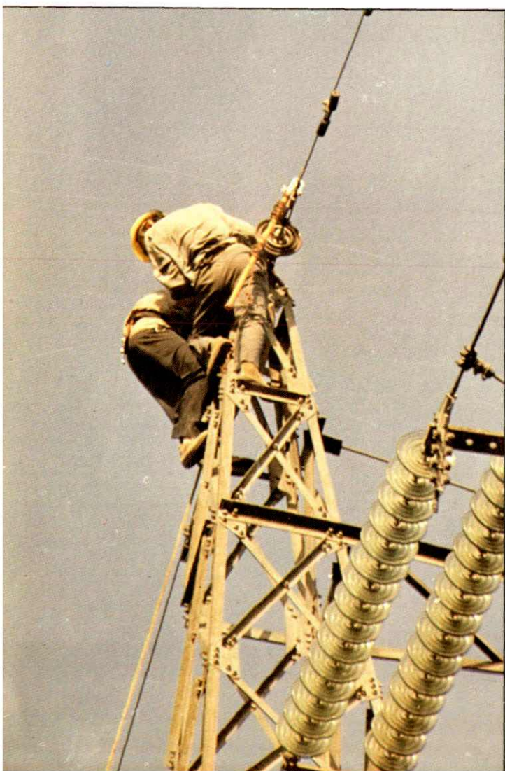
220 千伏线路带电作业
