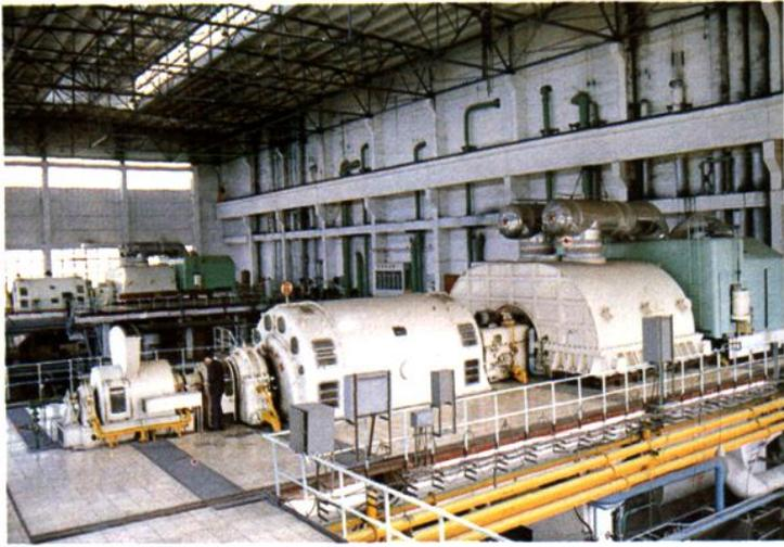
安装在三车间内的2台12.5万千瓦超高压机组
