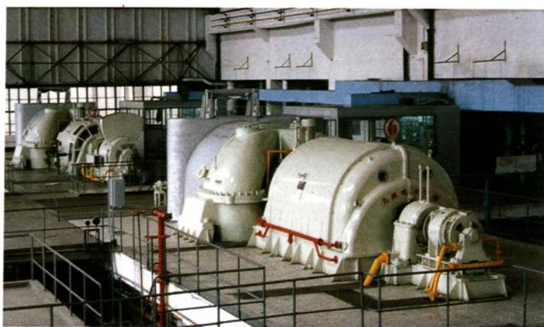
安装于二车间的2台2.5万千瓦汽轮发电机组
