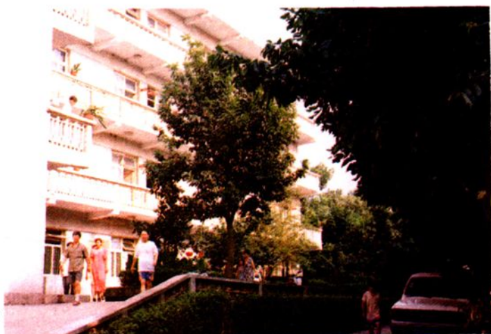
双河煤矿十井
