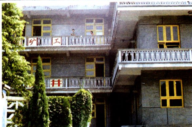
双河煤矿八井
