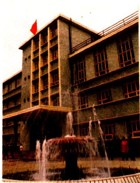
隆昌煤矿办公楼
