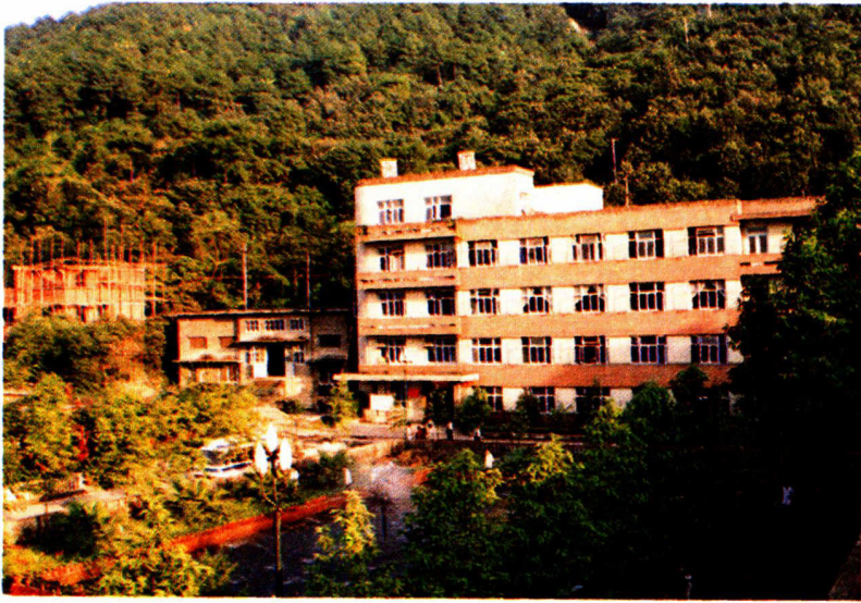
永川煤矿六井
