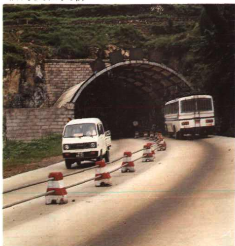
临海桐岩岭隧道
