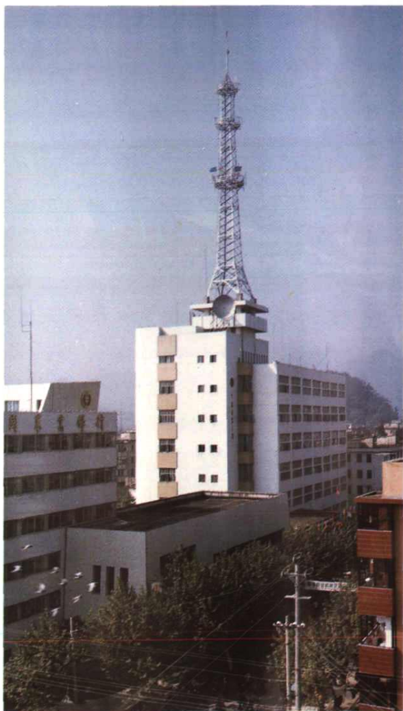
台州电信大楼
