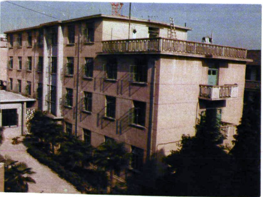
奉贤县供销办公大楼
