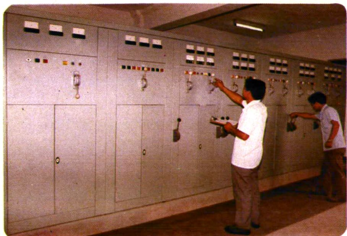
· 齐贤轧花厂中心控制室
