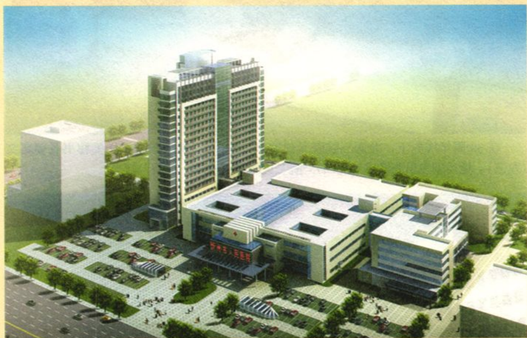
正在新建的忻州市人民医院综合楼鸟瞰图
