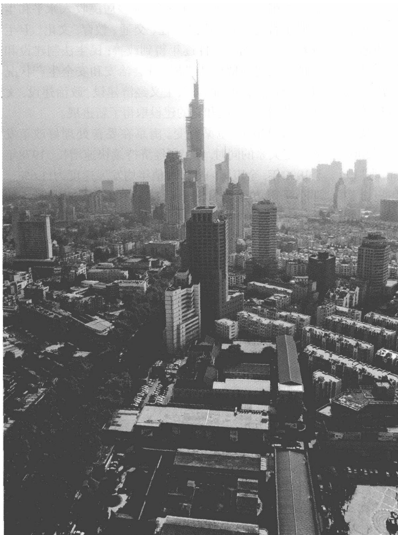
2008年正在建的紫峰大厦，以超越紫金山的450米高度，成为南京城市发展的最新标志
