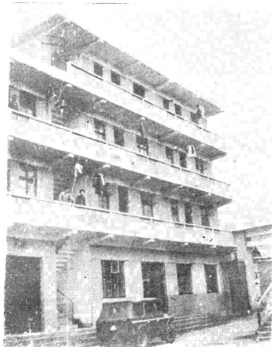
流丰粮站宿舍楼
