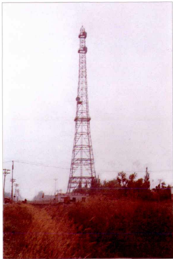
1992年新建的微波通信铁塔
