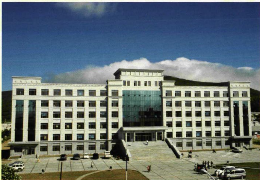
2005年动工兴建的农场机关办公楼。
