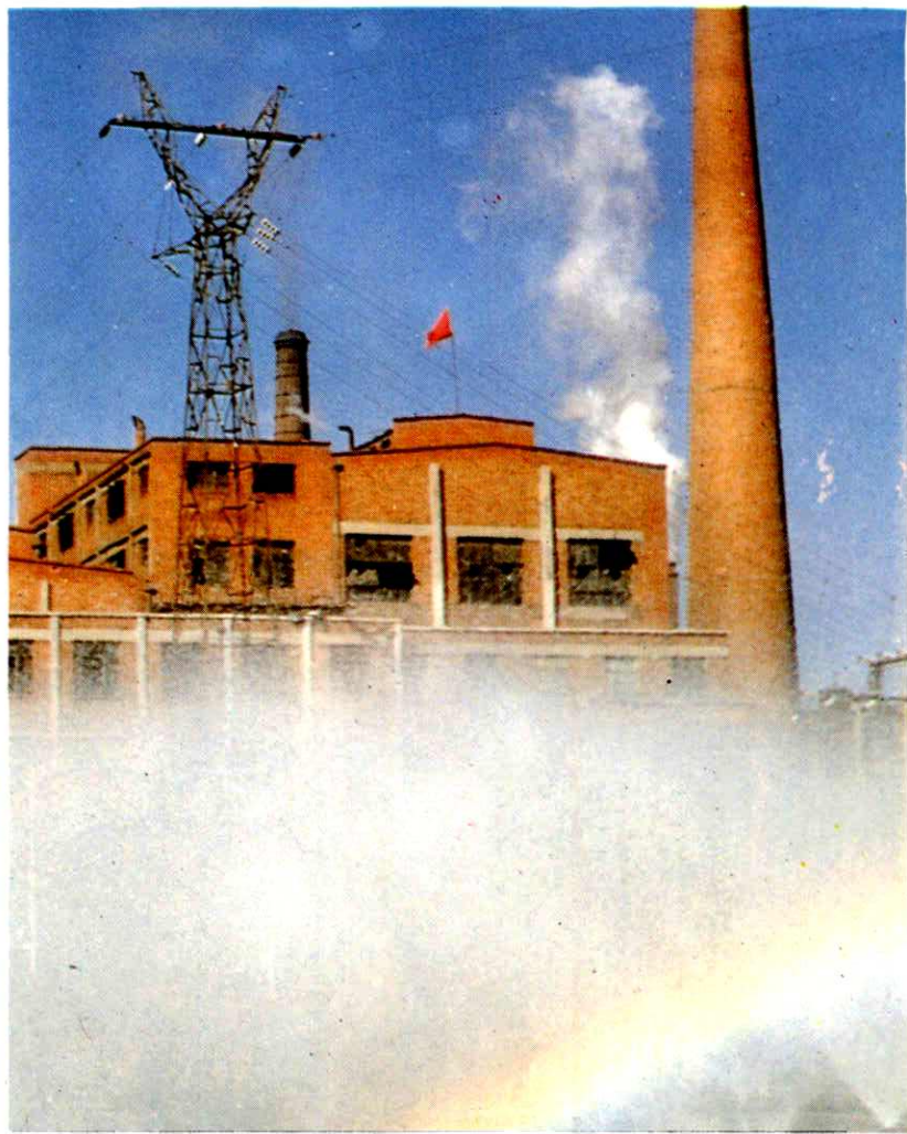
新建的热电厂
