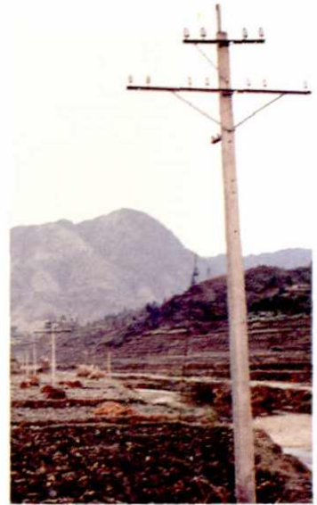
1984年建成的第一条农话滚贝至杆洞中继水泥杆路
