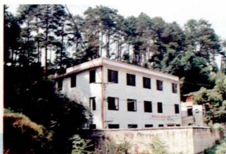
1996年扩建的拱洞邮电所
