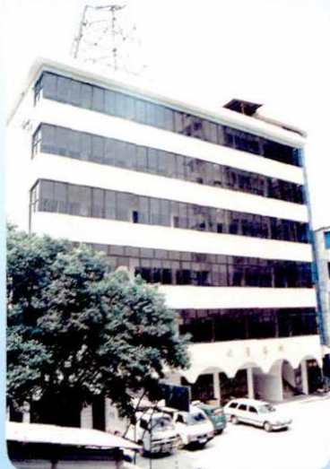
1994年新建的融水苗族 自治县邮电局电信生产综合 大楼，建筑面积2394平方米
