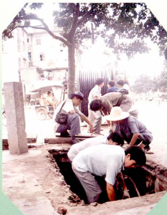
干部职工参加市话管道电缆布放
