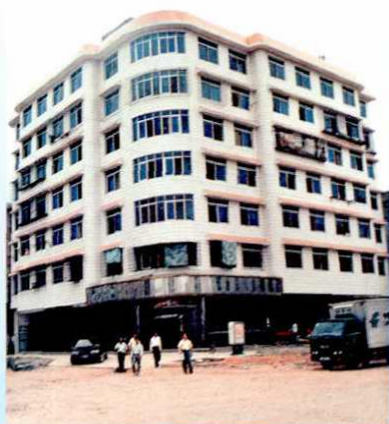
1997年兴建的高岭头 邮政综合楼
