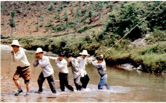
为实现“乡乡通光缆”，施工人员爬山涉水，以苦为乐
