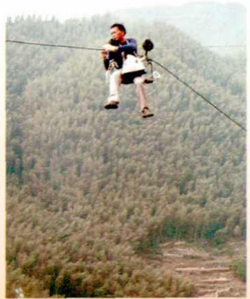
施工人员坐在几十米高的滑车上架挂光缆
