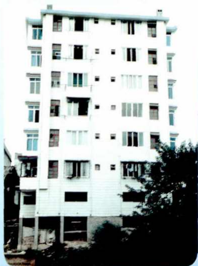
1997年在大南街19号新建7 层3房一厅邮电职工宿舍，总建筑 面积926平方米
