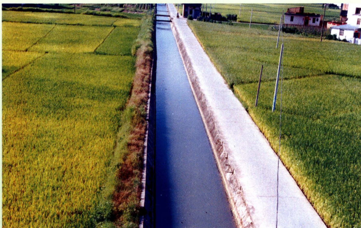
蕉岭县长潭干渠支渠
