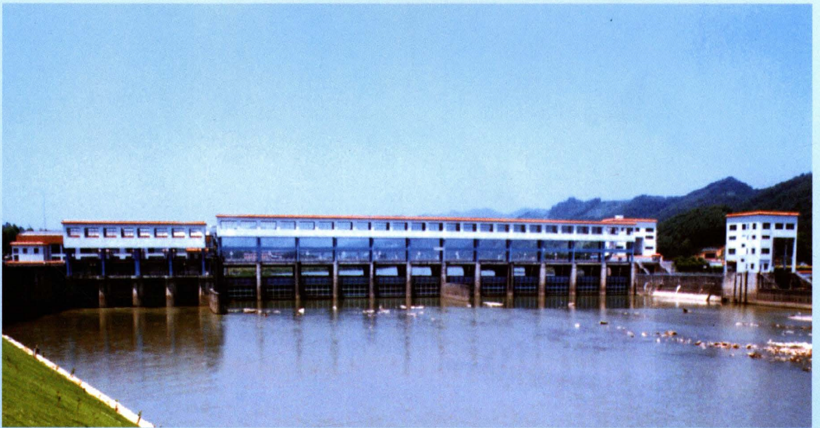
梅县西阳水电站
