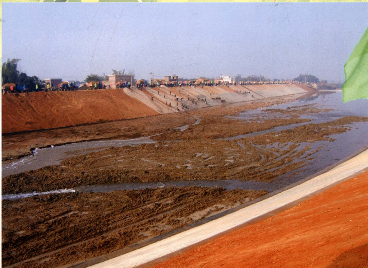
2004年1月，兴宁市宁江陂新联围新北段施工现场。
