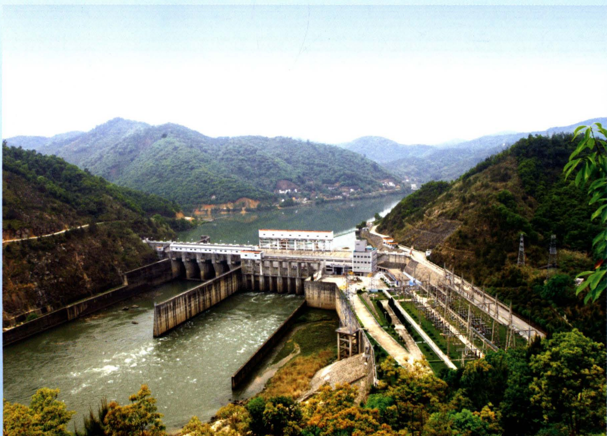
广东省青溪水电站（唐业能摄）
