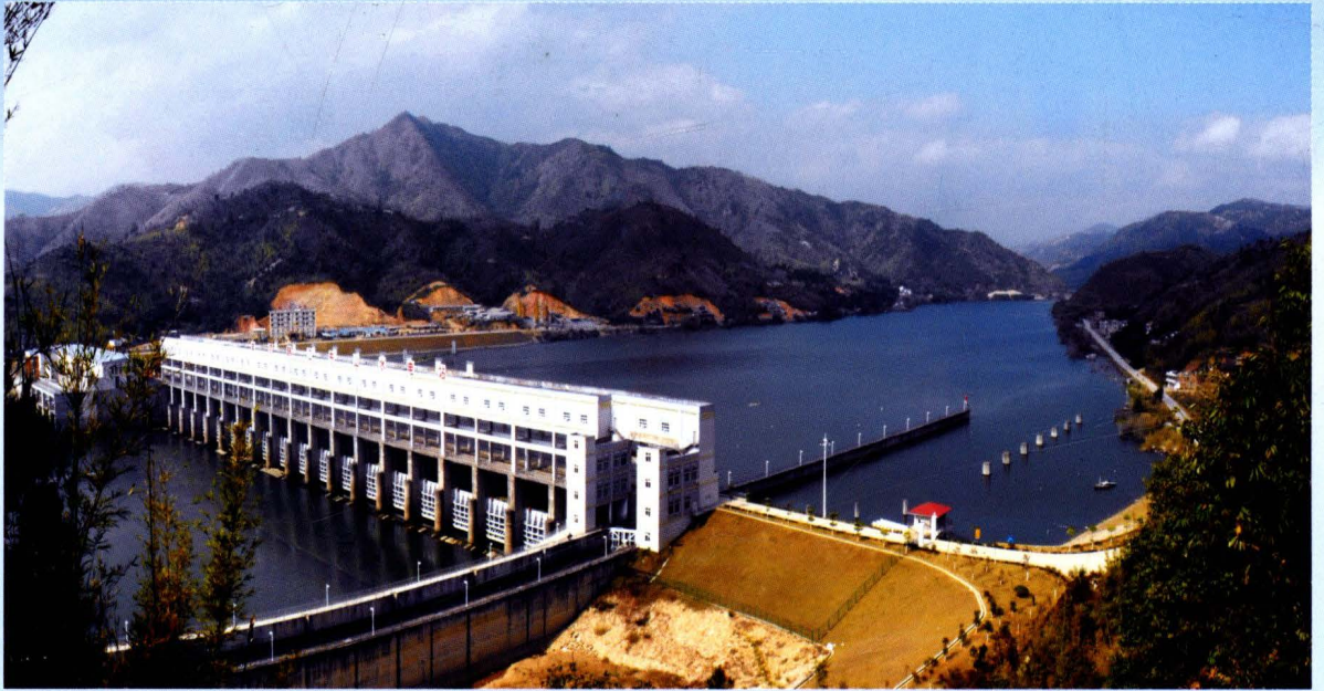
丰顺韩江东山水利枢纽工程（大坝上游）(张佳胜 张双喜摄)
