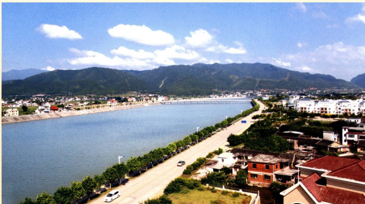
2006年，蕉岭县河东河西联围除险加固工程完工。图为联围蕉城段
