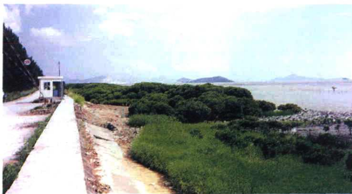
◀ 1988-1993年建成的宝安西海堤。全长27公里。图为西乡堤段。前有红树林消浪，后有防风林挡风。
