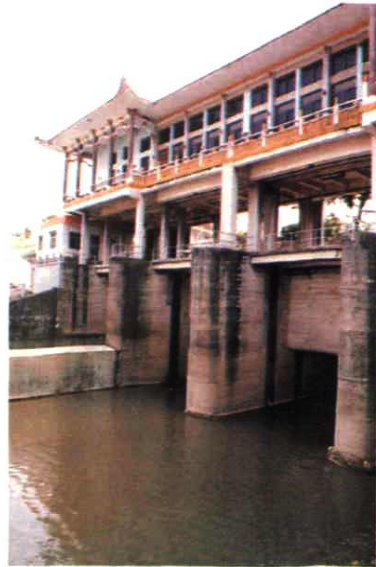
▼ 笋岗滞洪区洩洪闸
