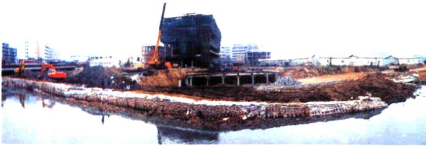
▲ 1995-1996年兴建的罗雨泵站及布吉河口工程。上图为施工中的布吉河河口，下图为竣工后的布吉河河口。
