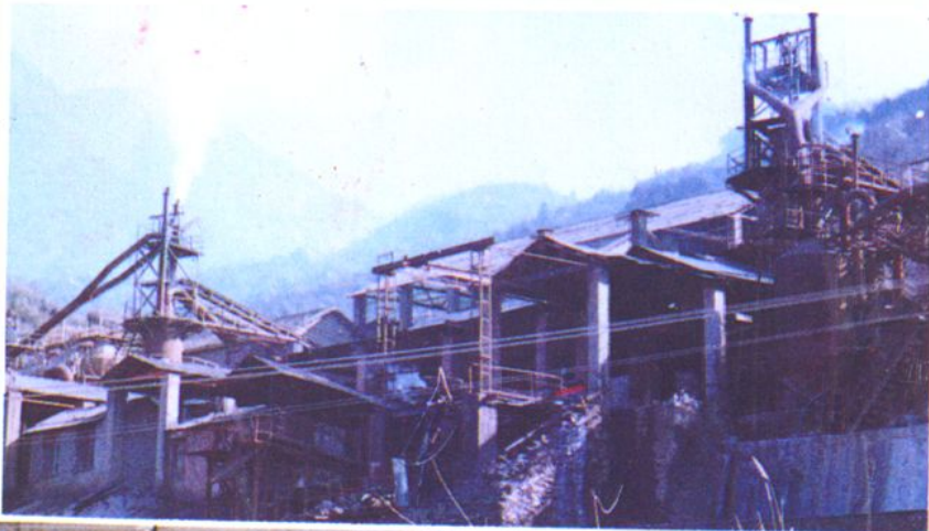
玛瑙山锰矿小高炉 冶炼富锰渣
