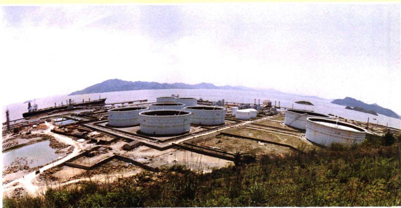
岙山石油储运基地
