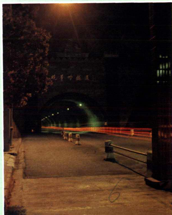
衔接329国道的 晓峰岭隧道
