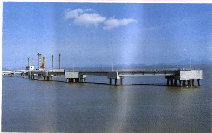
岙山石油转运基地25万吨级原油码头
