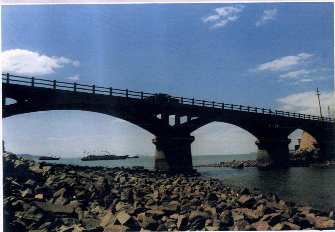
嵯泗李柱山跨海大桥
