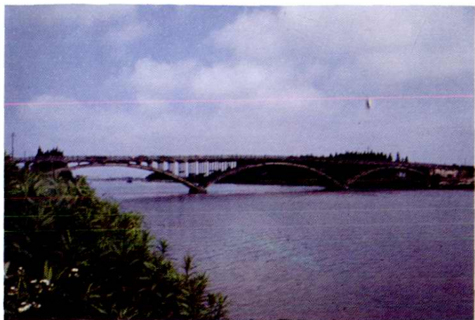
大治河三跨拱桥
