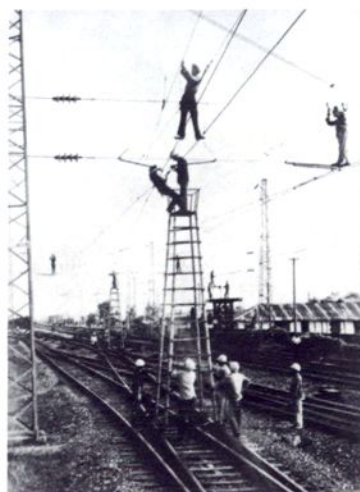
1983年5月，职工们在襄渝线安（康）达（县）段进行接触网施工。
