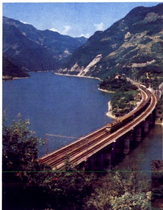
1977年6月25日，中国第一条新线电气化铁路——阳安线通车。图为列车通过缙西河三线桥。
