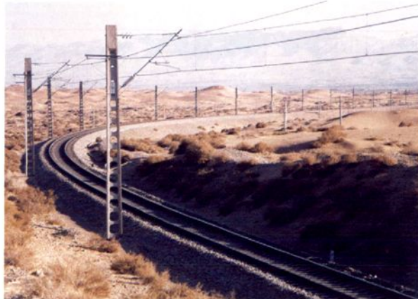
中国第一条沙漠地带的电气化铁路——干武线
