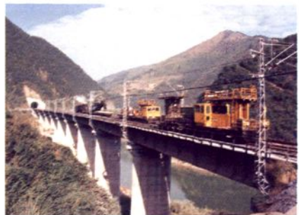
衡广复线郴(州)韶(关)段电气化工程,1990年获国家银质奖。图为在三层滩大桥上施工作业。
