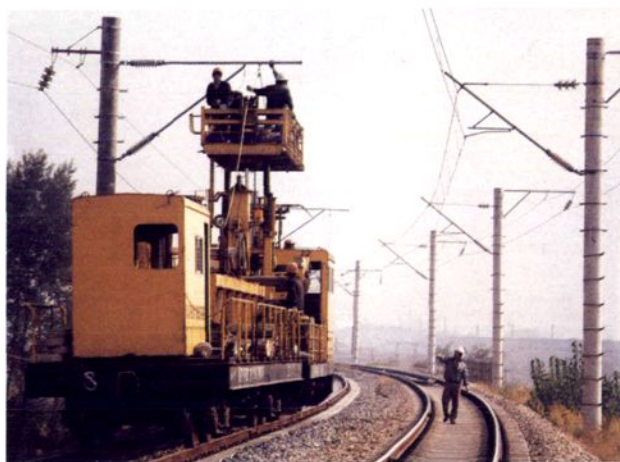
大秦线电气化铁路接触网施工。这是中国第一条采用国际八十年代先进技术，自行设计、施工，开行重载单元列车的双线电气化铁路。1997年获中国建筑工程鲁班奖。
