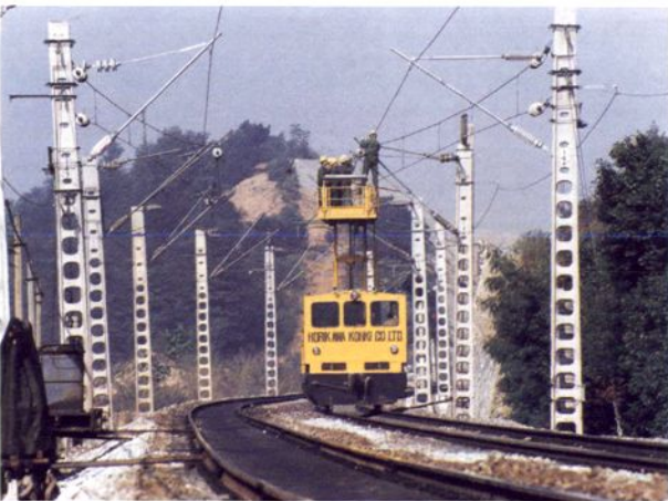
武广电气化铁路区间接触网施工
