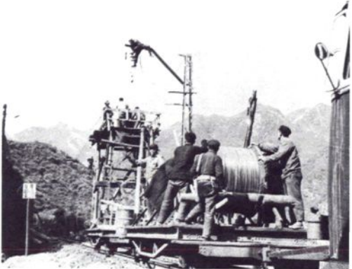
1959年，工人们在宝成线宝（鸡）凤（州）段采用自制的架线车放线作业。
