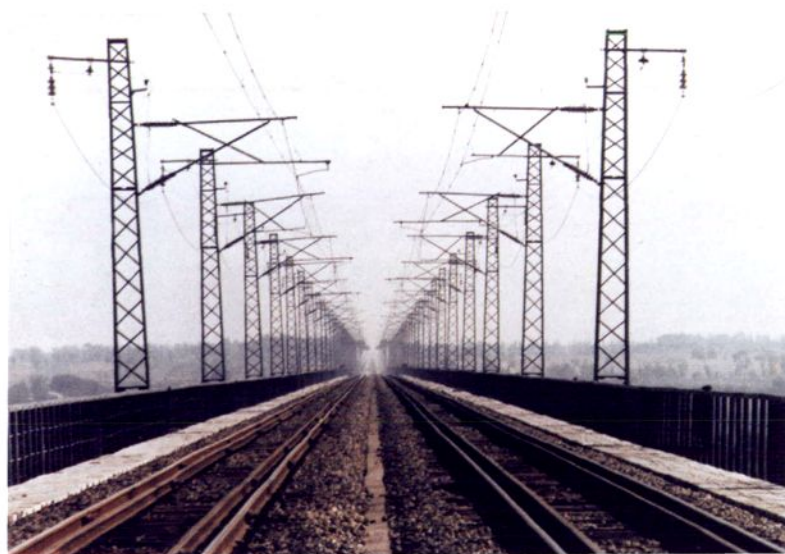
大秦线御河桥接触网
