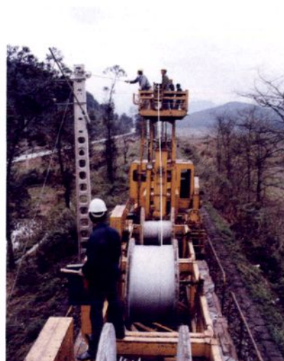
鹰厦线电气化铁路接触网架线施工
