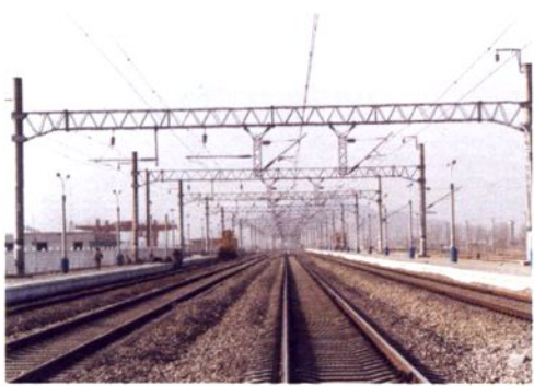
京秦电气化铁路抚宁车站
