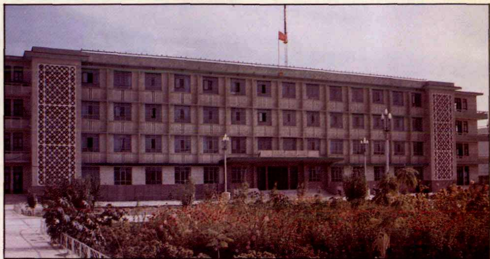
中共若羌县委、县人民政府办公楼
