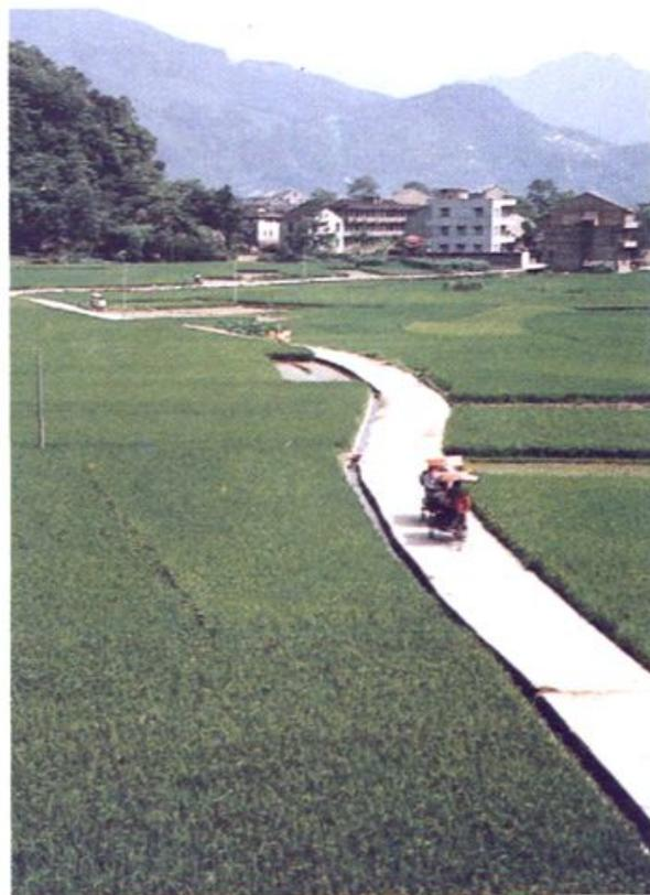
水泥混凝土路面机耕路
