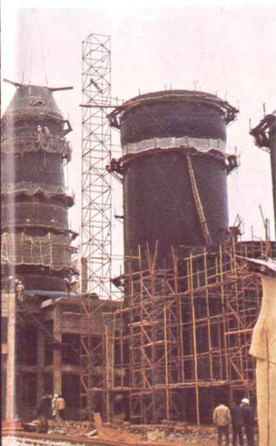
新余钢铁厂600立方米高炉 至年底，高炉主体胜利竖起。
