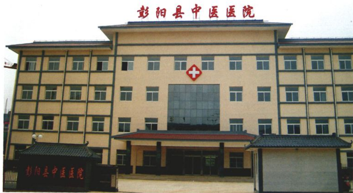
▲ 新建的彭阳县中医医院
