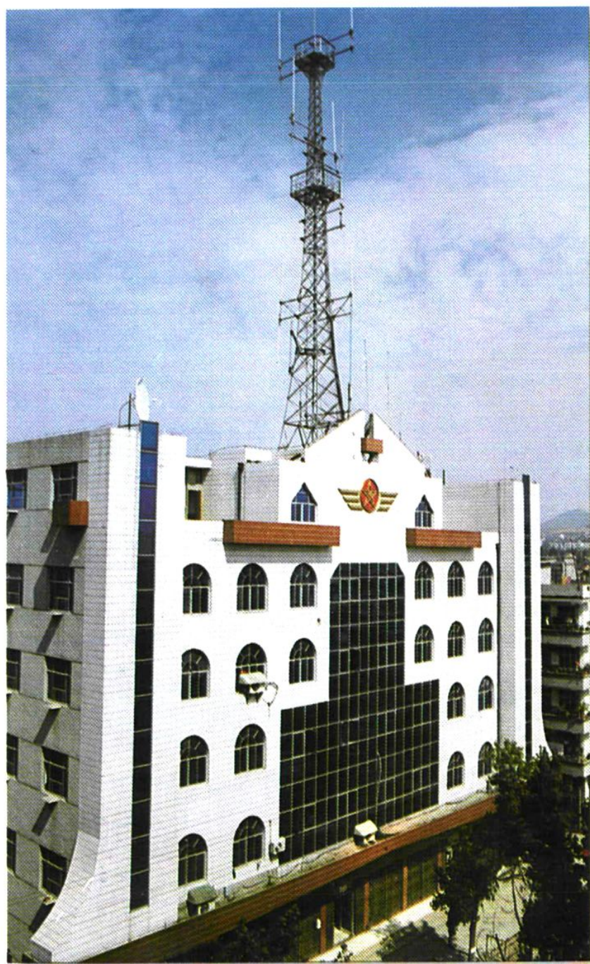
郟县邮电局邮政大楼
