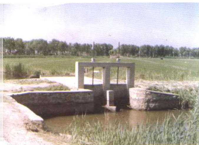
蓄水深渠节制闸
