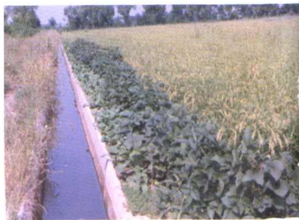
田间防渗渠道
