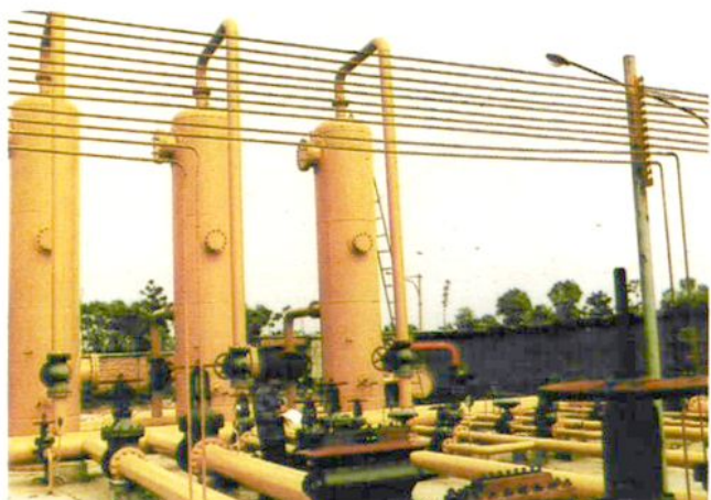
安阳 105 公里的输气管道
