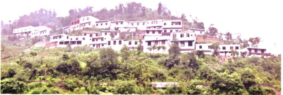
金坪村地震恢复重建新居 (周元江 摄)
