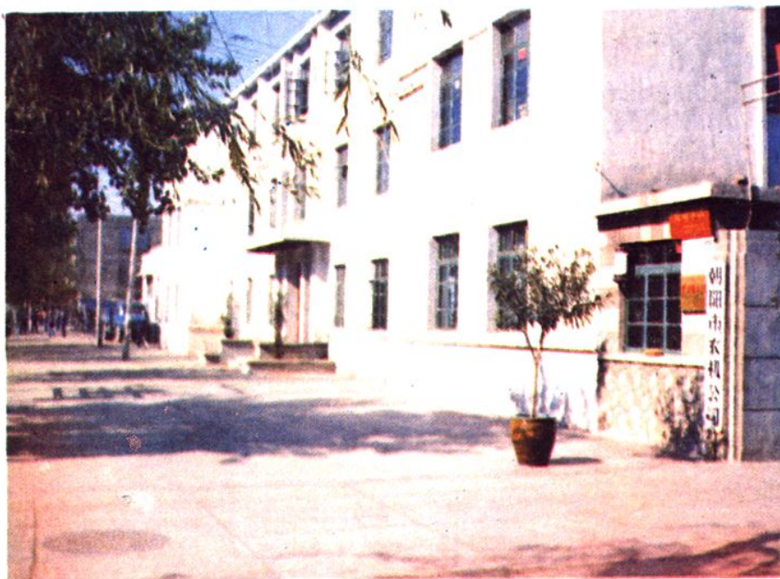
市农机局、农机公司办公楼
