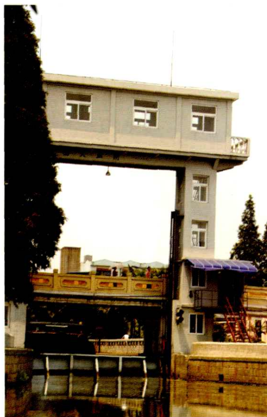
赵屯西大盈水闸
