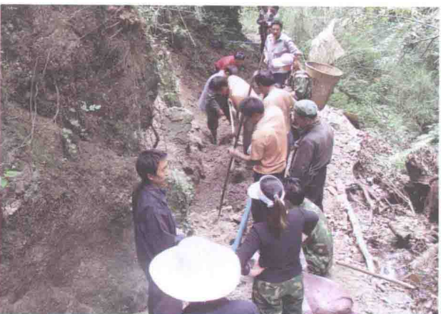
组织抢修村民饮水管道
