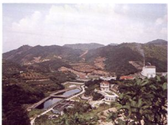
联合国工业发展署对华援助项目漳州市九龙岭生活垃圾无害化综合处理场。
