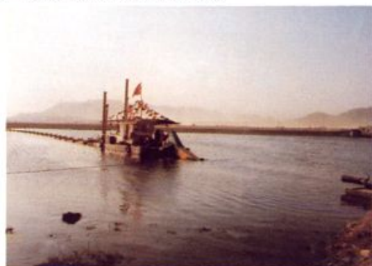
1984年11月,厦门筴筴湖开始采用绞吸式挖泥船清挖湖中污泥。
