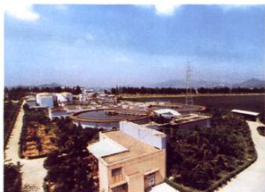
1989年7月,福建省第一座建成的厦门市污水处理一厂投入运行。
