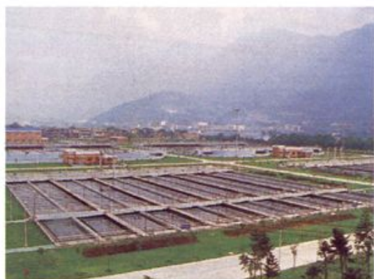
福州市实施水环境治理的核心工程——福州洋里污水处理厂。
