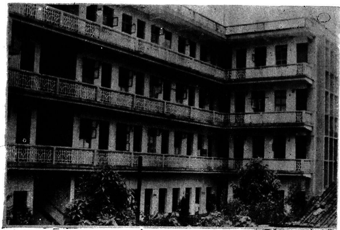
兴宁县供销社联合社办公大楼
