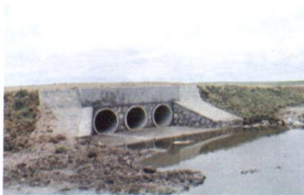
后的管涵。 通局抢修重建该段涵。图为建设成 往东乌旗、乌拉盖的唯一通道,交 柴达木南管涵被水毁,该线成为通 1998年的洪灾中,巴—霍线
