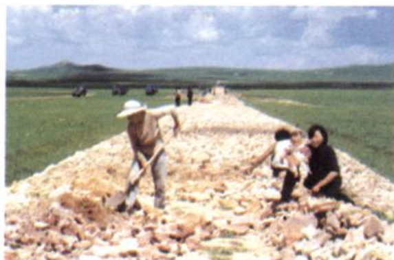
西乌旗政府动员牧民大搞民工建勤修建苏木道,图为牧民建勤修路现场。
