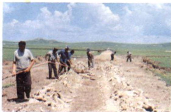
牧民摊铺路面基层料
