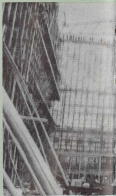
一期工程，锅炉车间厂房在施工
