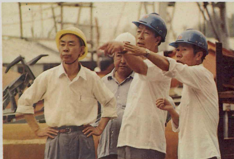
内蒙古自治区 副主席刘作会，内 蒙古电业管理局局 长崔振祥在施工现 场听取基建副厂长 张立文工作汇报。
