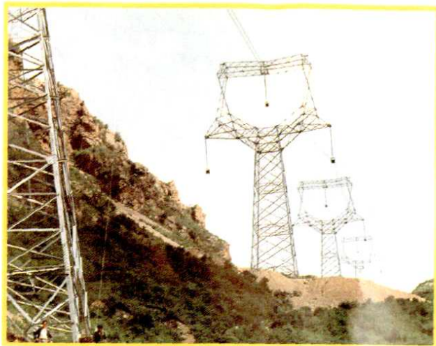
500 千伏工程转角放紧线施工作业
