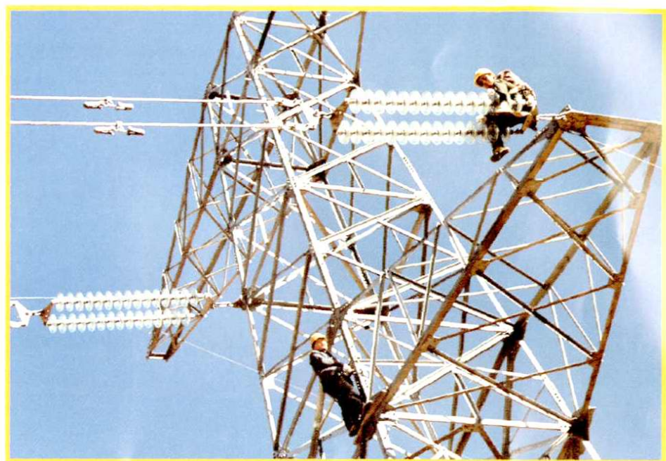
送电工正在进行塔上作业
