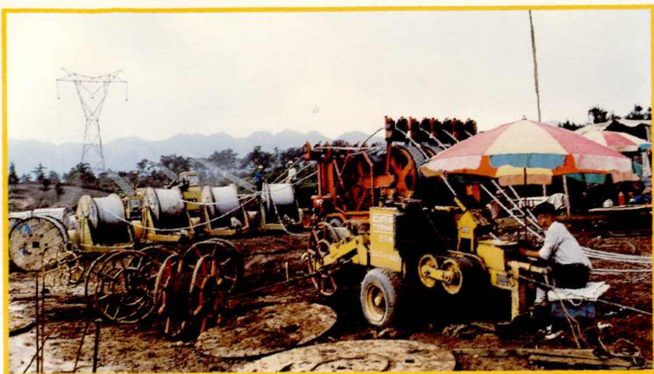
500 千伏输电线路 张力放线施工现场
