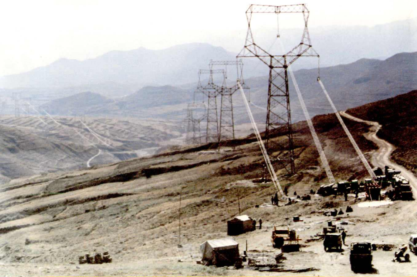
公司承建的太原至神头 500 千伏输电线路张力放线施工场面
