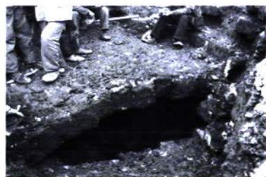
20世纪80年代挖出淤没的古高公桥
