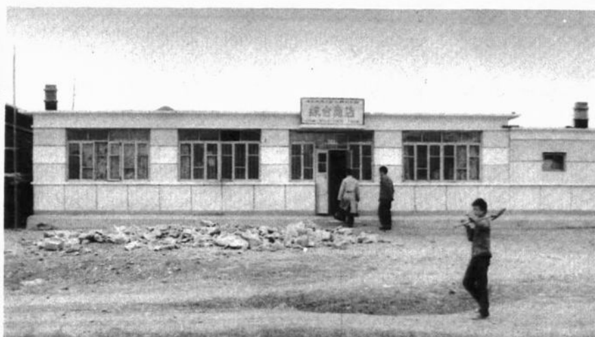
建昌县药王 庙物资供应站
