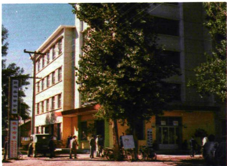
朝阳县物资 局办公楼
