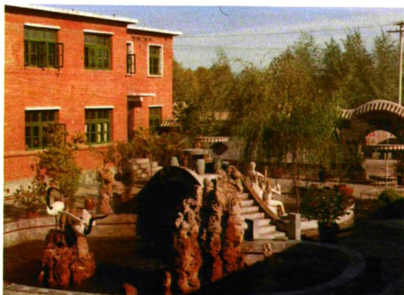
喀左县燃料 公司办公楼
