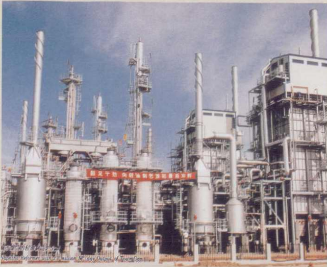
石洞口煤气厂
