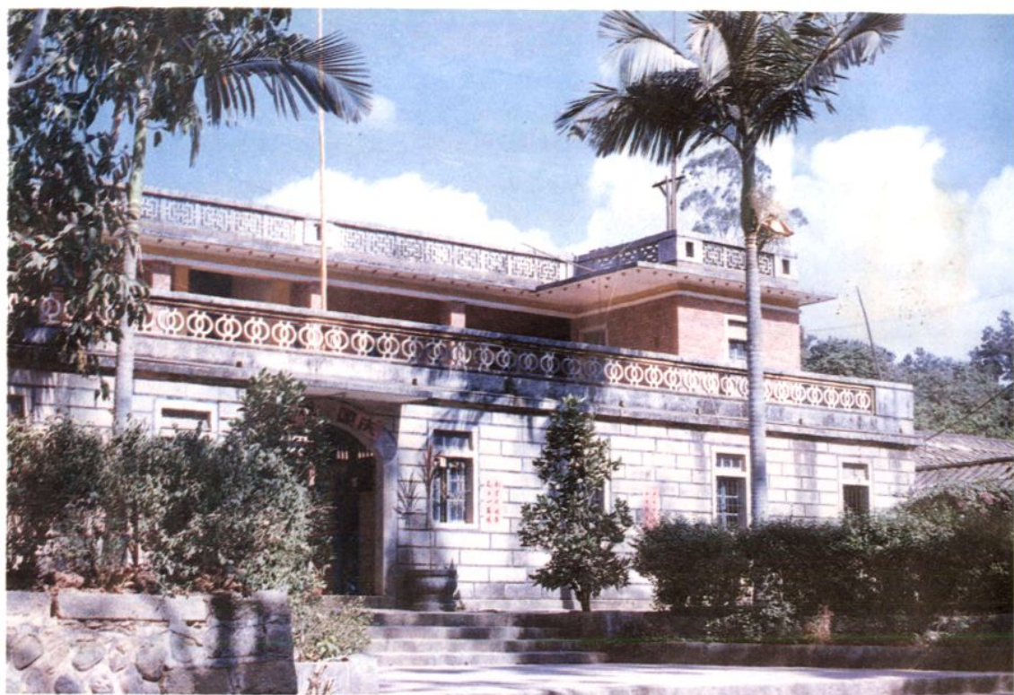
国营厦门市汀溪防护林场办公楼一角
