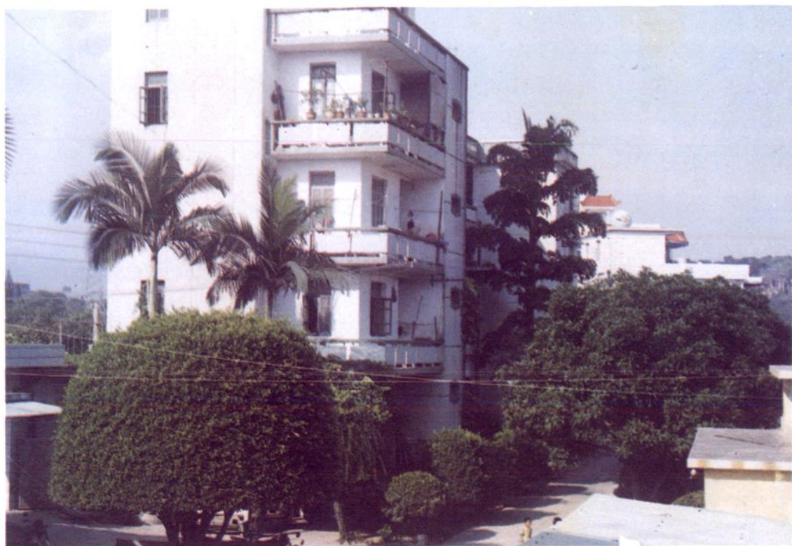
同安县林业局办公楼
