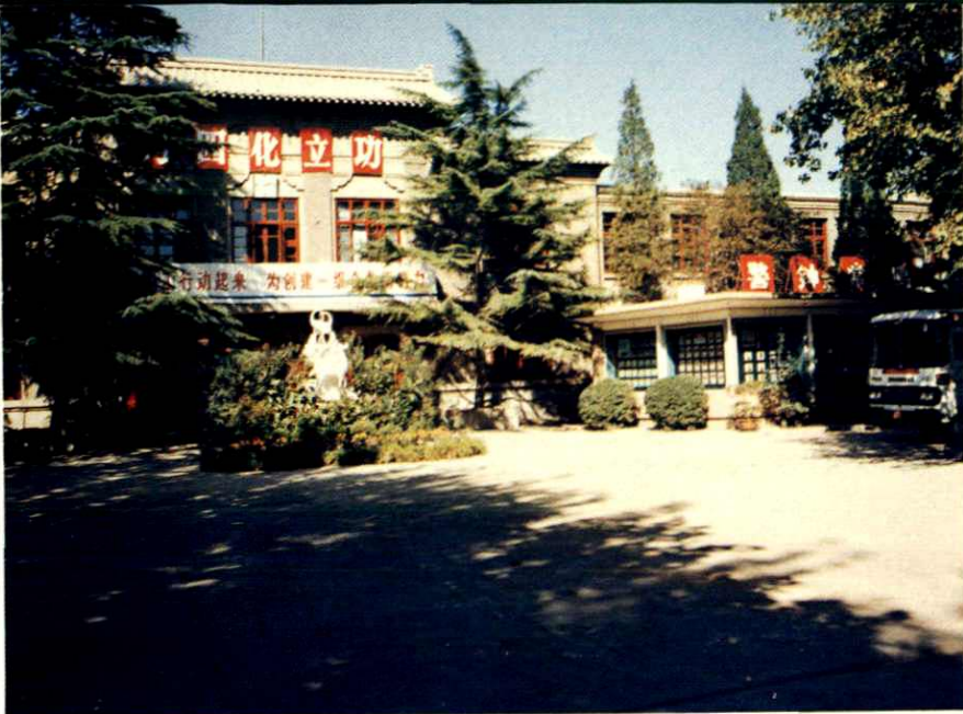
厂办公楼前景
