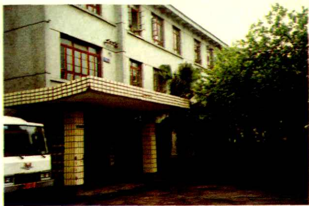
东兴区社办公楼
