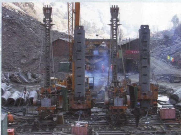
2005年，基础局施工的四川 狮子坪水电站主坝混凝土防渗墙是 当时国内第一道深度超过100米的防 渗墙
