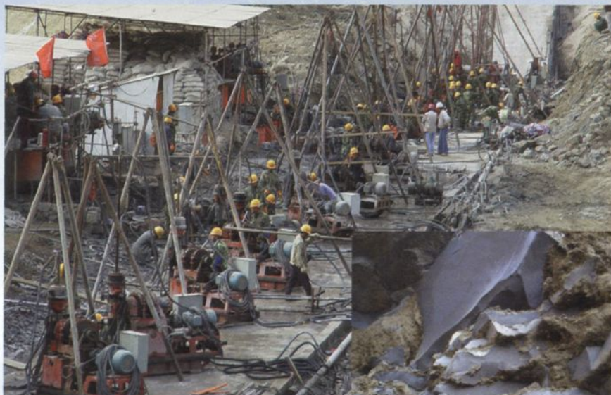
2005年，云南小 湾电站下游围堰灌 浆工程施工
