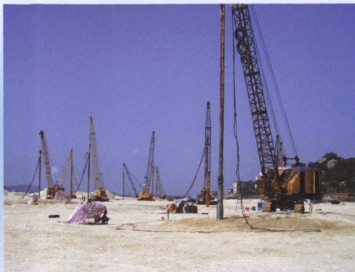
2004年，福建LNG围海造地振冲挤密工程施工
