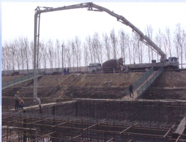
南水北调中线一期工程天津市1段 四标浇筑
