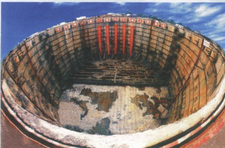
2004年，武汉阳逻长江公路大桥南锚碇地下连续墙开挖
