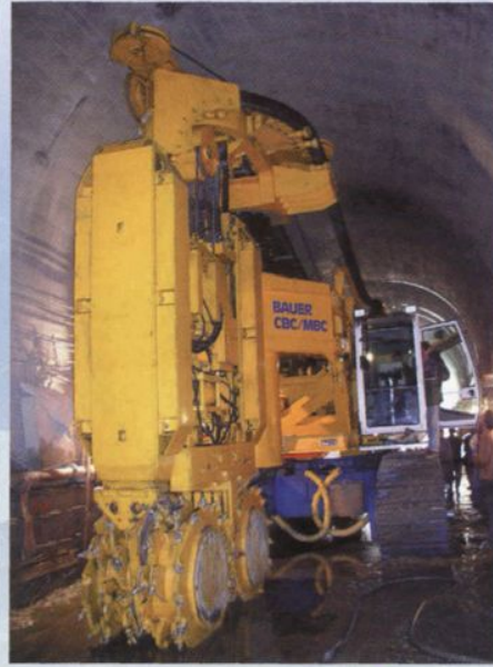
2003年，四川冶勒水电站廊道内混凝土防渗墙施工
