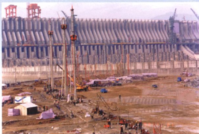
2004年，长江三峡三期围堰振动高喷防渗墙施工
