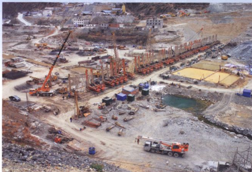
四川泸定水电站大 坝基础防渗墙工程施工
