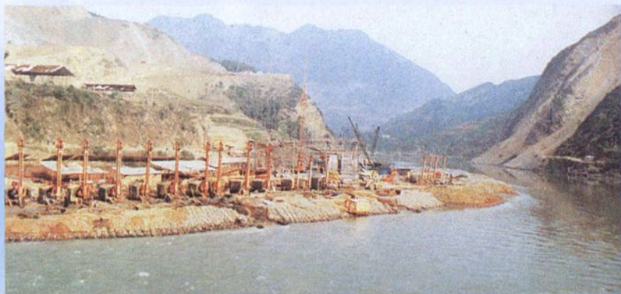
1991~1992年，四川宝珠寺水电站左岸 下游护坡防冲墙施工
