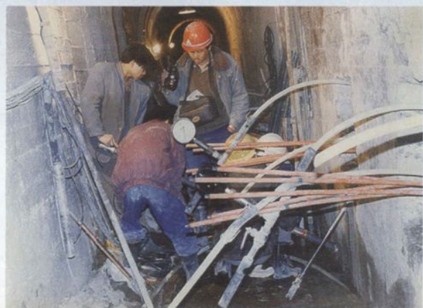
1999年，北京珠窝大坝加固工程安设锚杆测试仪器
