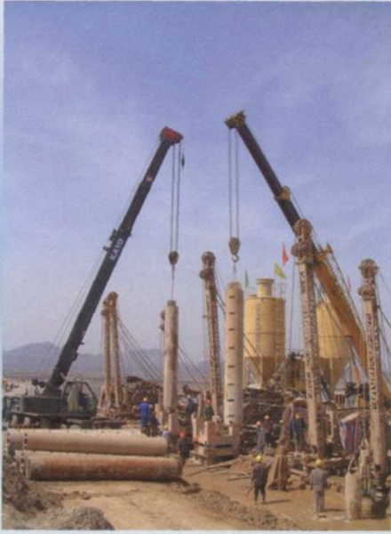
2003年，河北黄壁庄水库除险加固工程混凝土防渗墙施工
