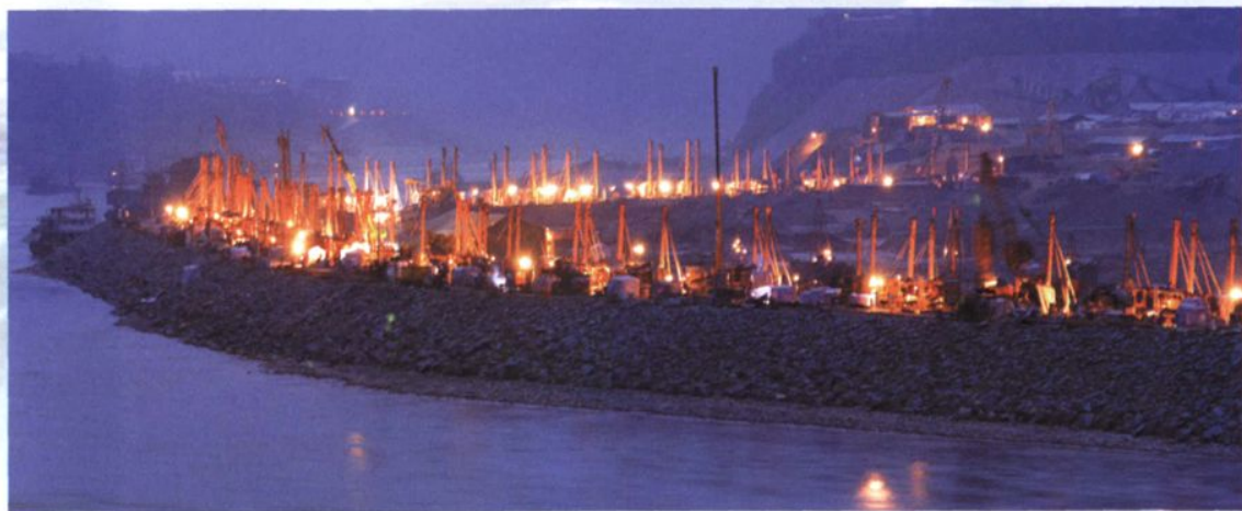
2005年，四川向家坝水电站一期围堰防渗墙施工夜景
