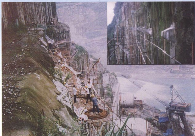
1993年，湖北隔河岩水电站高边坡锚索加固施工
