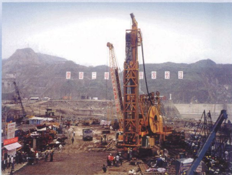
1996年，长江三峡水利枢纽二期上游围堰混凝土防渗墙工程
