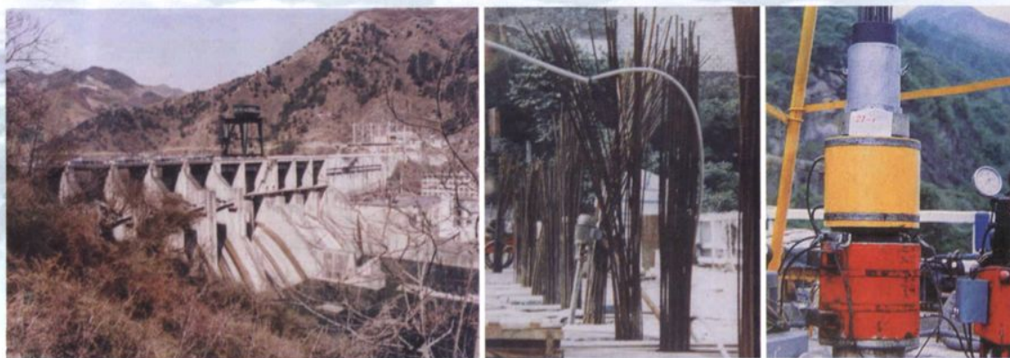
1995年，陕西石泉水电站6兆牛与8兆牛级预应力锚索工程
