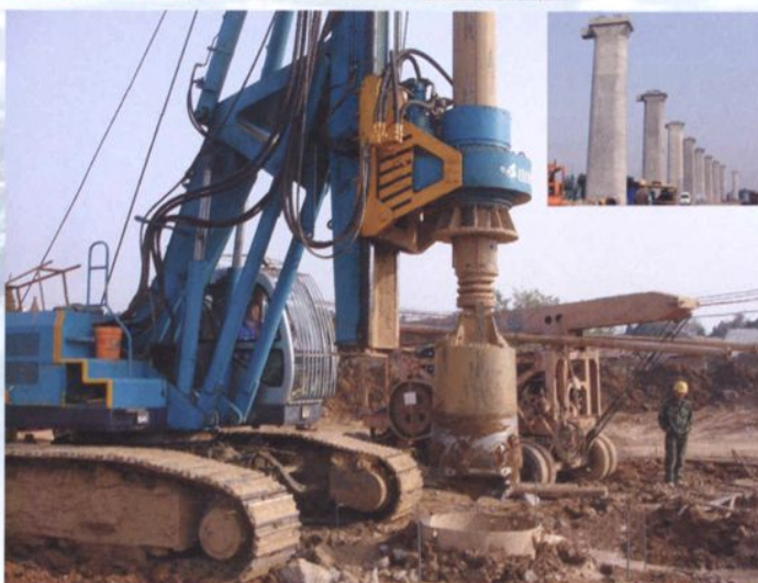
京沪高速铁路基础 灌注桩施工
