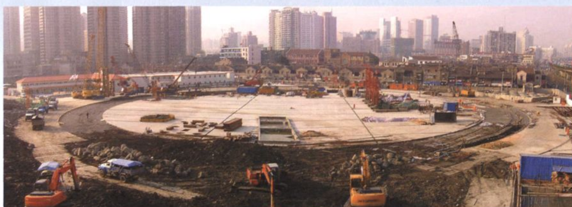
2006年，上海500千伏静安(世博)输变电工程地下连续墙工程施工
