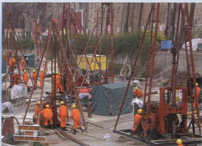
2005年，贵州东风水电站右岸 边坡加固处理工程钢管桩施工
