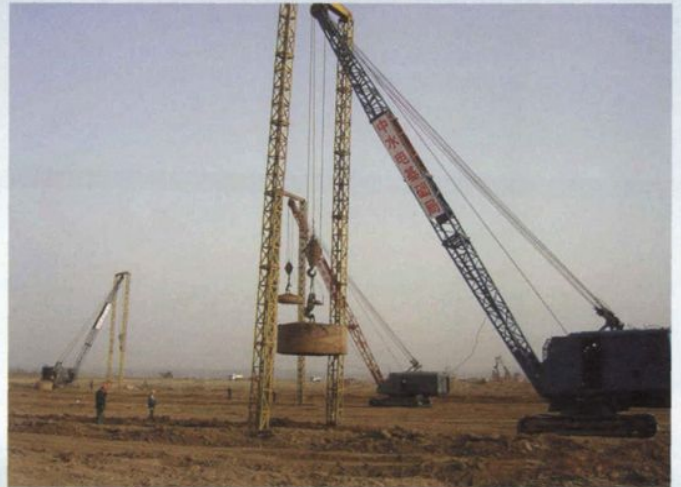
2003年，河北黄壁庄水库除险加固工程混凝土防渗墙施工
