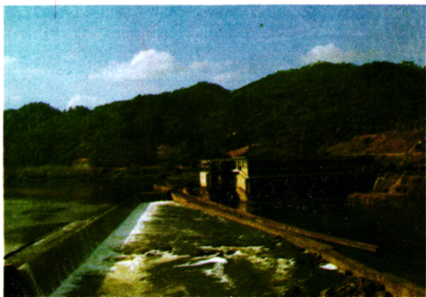
顺昌县贵岭水电站
