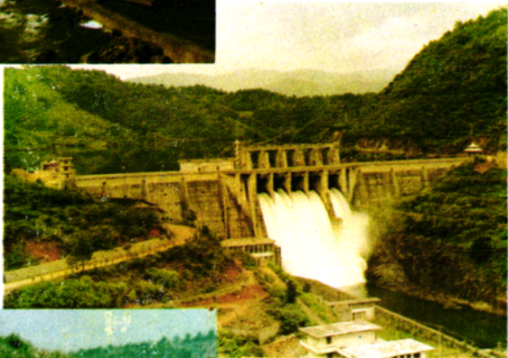
崇安县东溪水电站
