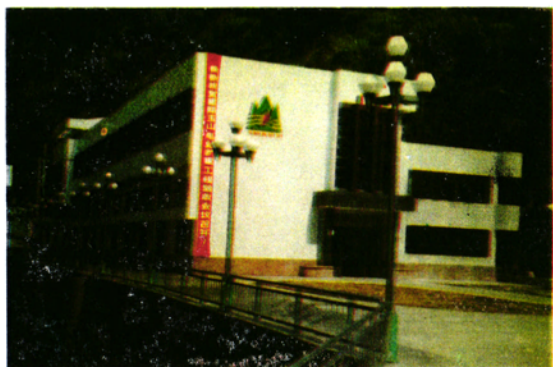
建瓯县玉山水电站
