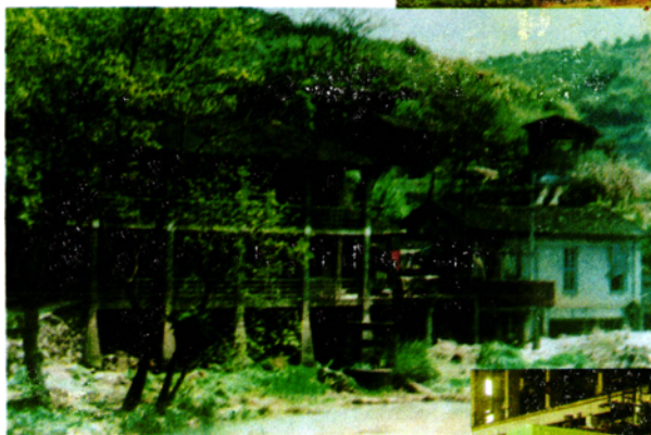
南平市西芹水电站外景
