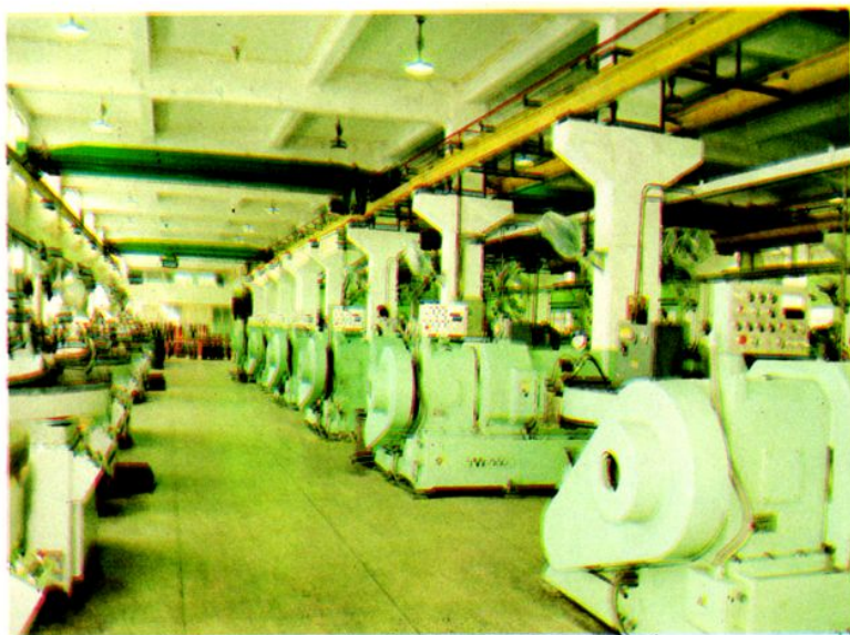
專機車間現場
