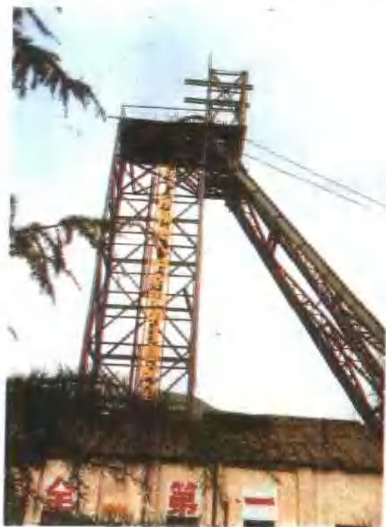
金口岭铜矿 矿山井架
